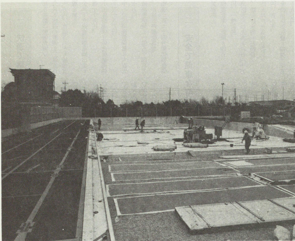
7月オープンをめざし工事が進む市民プール
